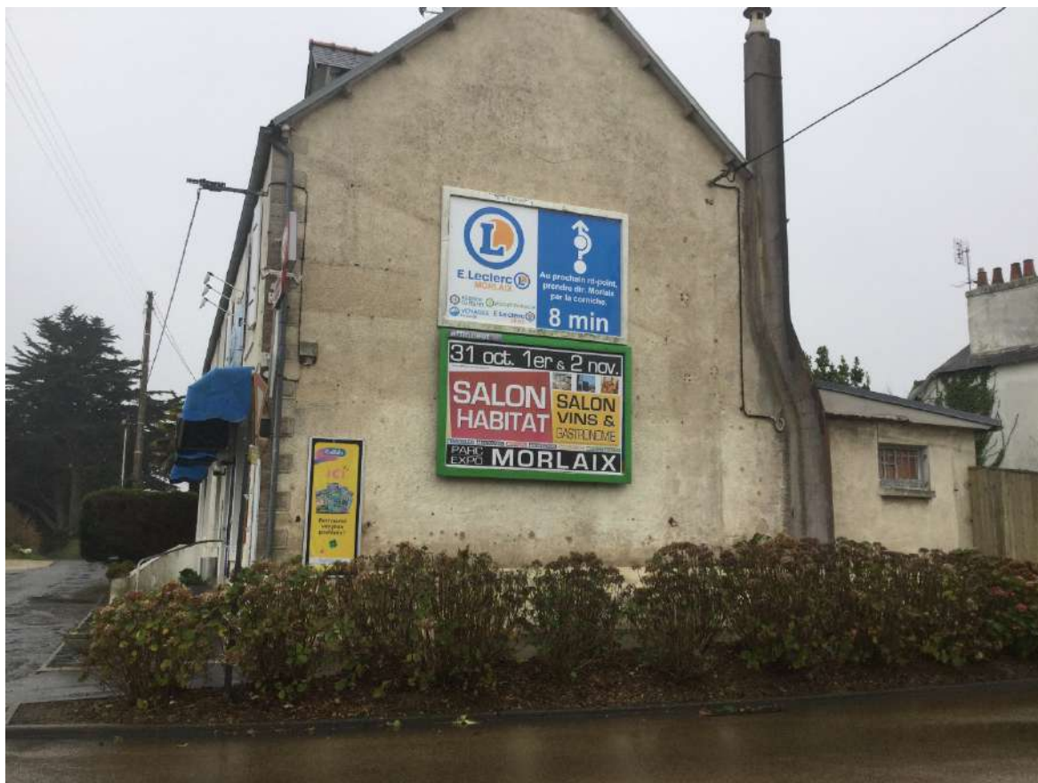
2 publicités/préenseignes sur mur alignées verticalement, Carantec, novembre 2020.
