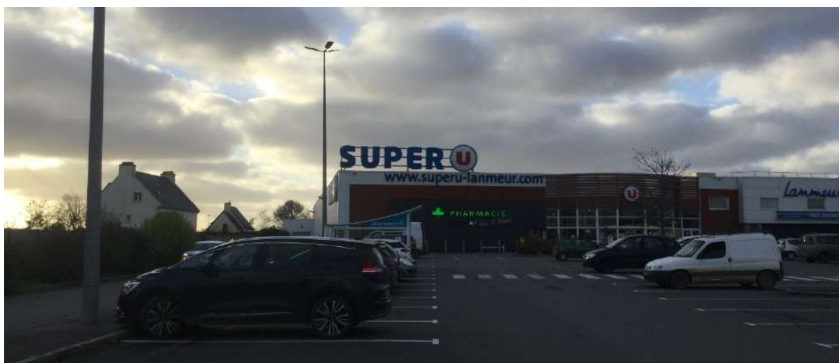
Enseigne sur toiture, Lanmeur, novembre 2020.
