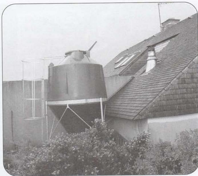
*Le silo extérieur d'une capacité de 3,5 tonnes*
