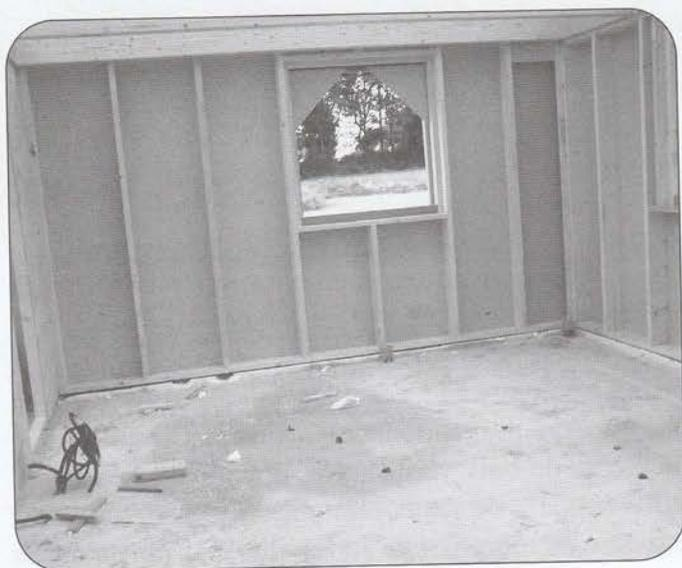
Combien de temps la construction ? Par rapport à une maison en briques ou en parpaings les délais peuvent être beaucoup plus rapides, pour deux raisons : selon le degré de préfabrication les délais peuvent être raccourcis de deux à trois mois, et il n'y a pas de délai de séchage avant d'aborder le second œuvre.
