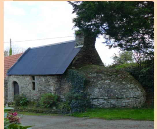
Le four à pain de Kerdudal (situé à l'Est de la commune)
