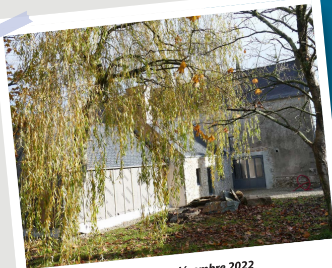
Les travaux, décembre 2022
